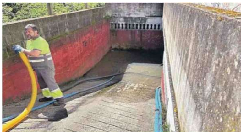
Un operario trabajando ayer en el subterráneo de Noria.
