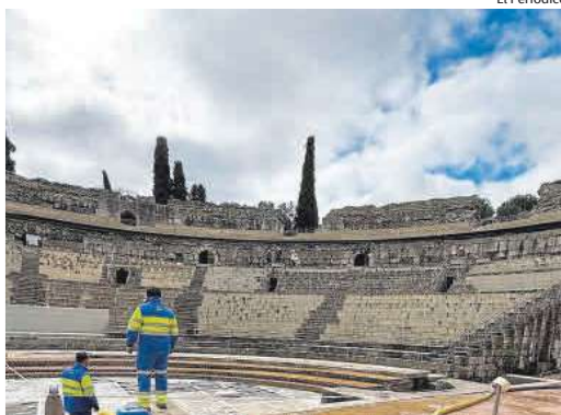
Operarios trabajan en el drenaje del subsuelo del Teatro Romano.
