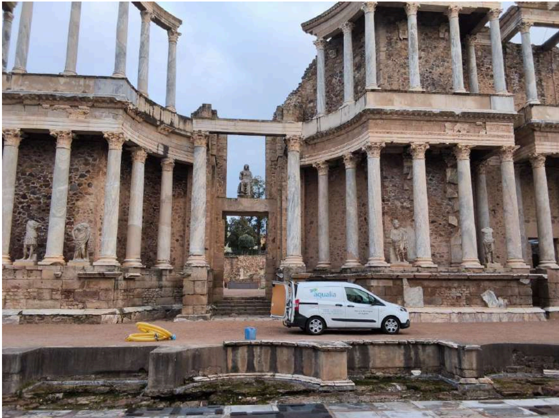
Aqualia lleva a cabo trabajos de saneamiento y extracción de agua en el Teatro Romano de Mérida | Aqualia
