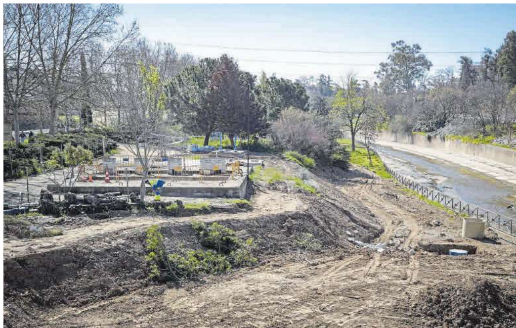
Estado de las obras en el colector del arroyo Rivillas finalizando sus intervenciones.
