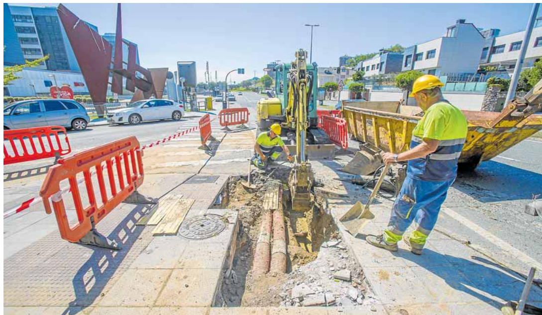
Varios operarios arreglan, el pasado verano, una avería en la tubería de Avenida de Valdecilla, que dejó sin agua a seis zonas de Santander. JAVIER COTERA
