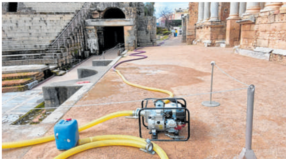
Actuación de Aqualia en las cloacas situadas bajo el frente escénico del Teatro Romano. HOY
